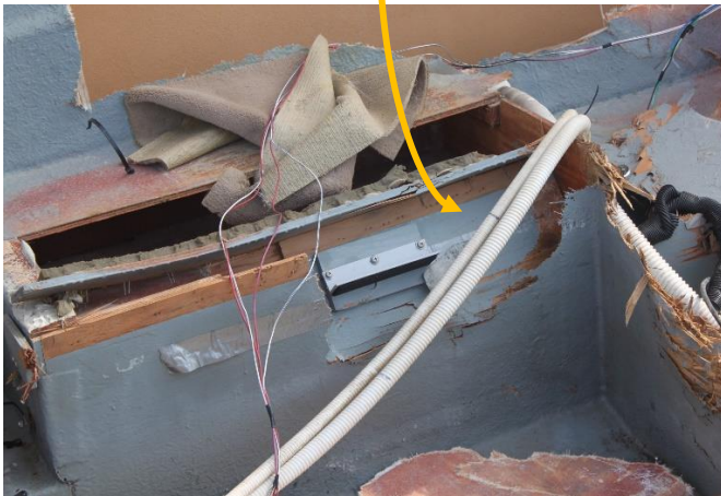
Mamparo longitudinal doblado, fibras de madera rotas hacia babor
