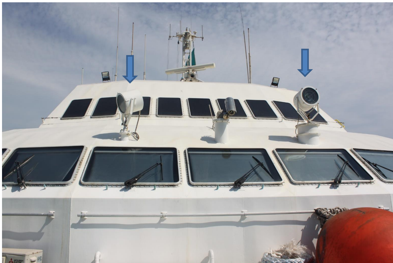
Figura 25. Focos dirigibles instalados en el NSD FORMENTERA DIRECT
