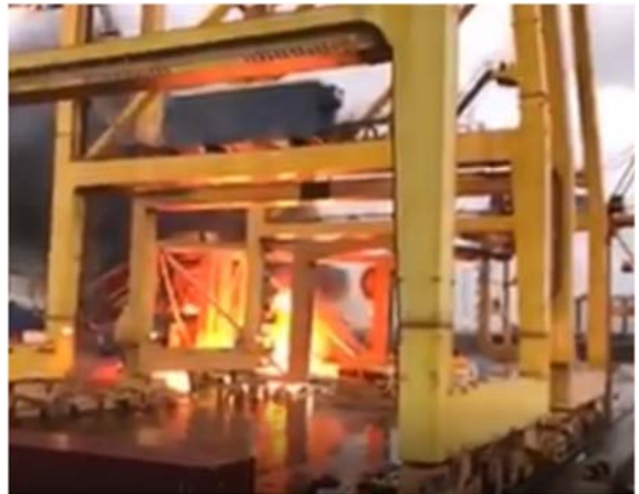
Figura 8. Derrumbe de la grúa
