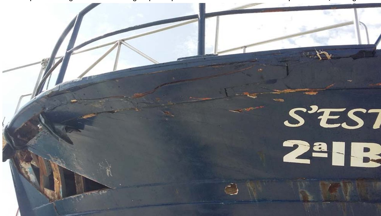
Figura 19. Daños en la obra muerta del casco producidos por el accidente del 15 de septiembre de 2018. En la imagen se puede apreciar la reparación de una rotura existente
