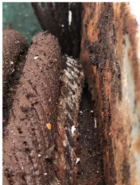
Figura 19. Cable en el tambor del chigre deteriorado y abierto.
