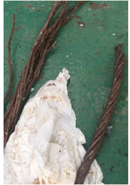
Figura 13. Estado del cable en las proximidades de la rotura. Puede observarse grasa seca y corrosión del cable interior que quedó al descubierto por el descordonado del cable
