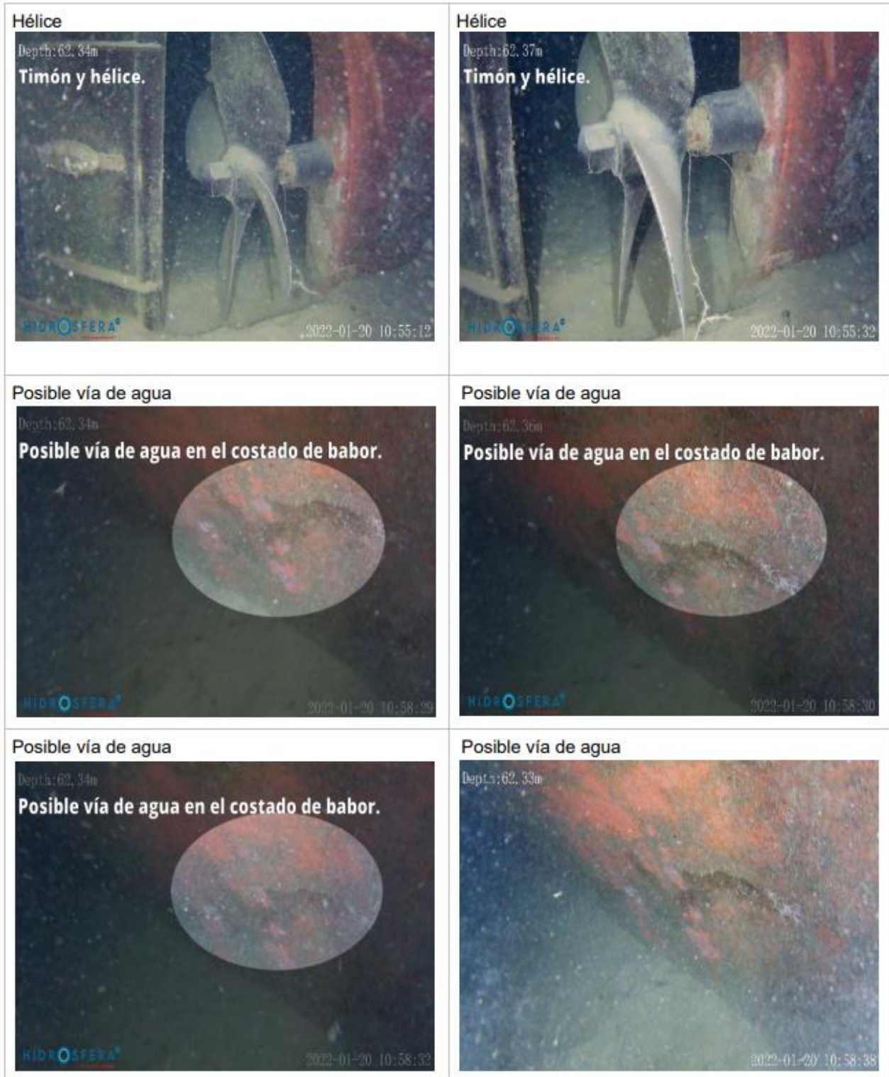
Figura 3: Detalles de la inspección submarina.
