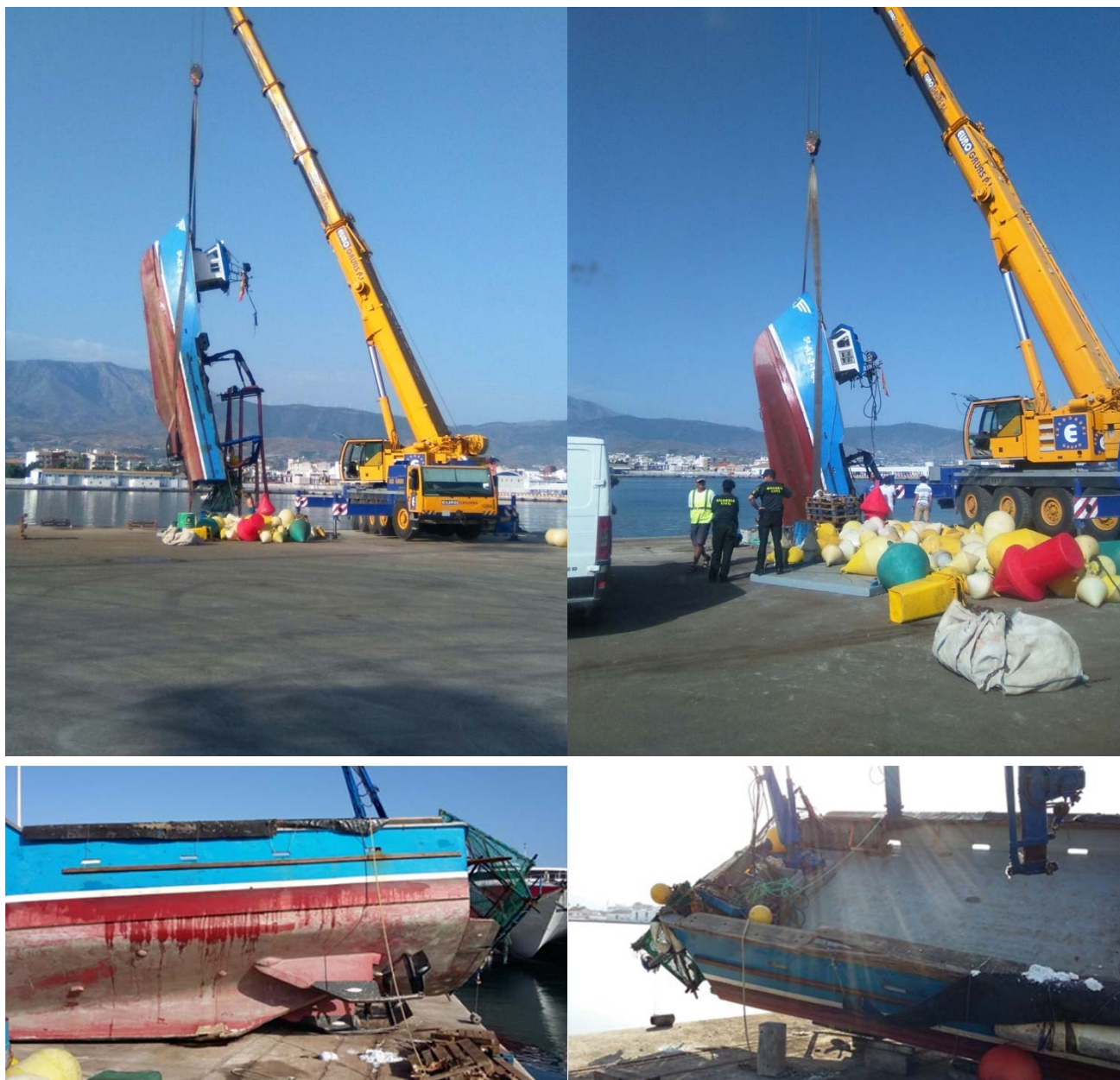
Figura 3. Imágenes del reflotamiento y depósito de la embarcación sobre el muelle.
