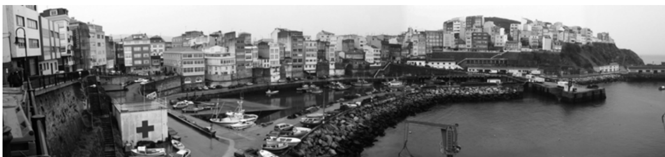
Figura 10. Imagen panorámica antigua que muestra la dársena interior con la rampa de varada
