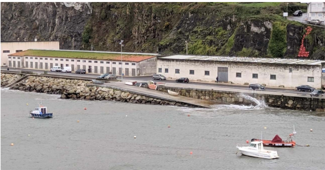
Figura 15. Reflexión de olas en el interior del puerto de Malpica, frente a la entrada de la dársena interior, en una zona en la que no hay escollera, el 20/12/2018
