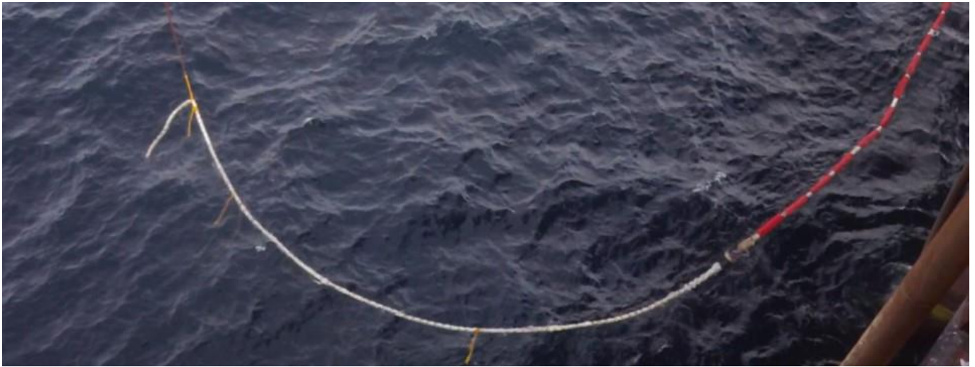
Figura 7. Prueba de flotabilidad de los cabos de sacrificio, el 8 de abril de 2021 [Fuente: ENAGÁS TRANSPORTE]
