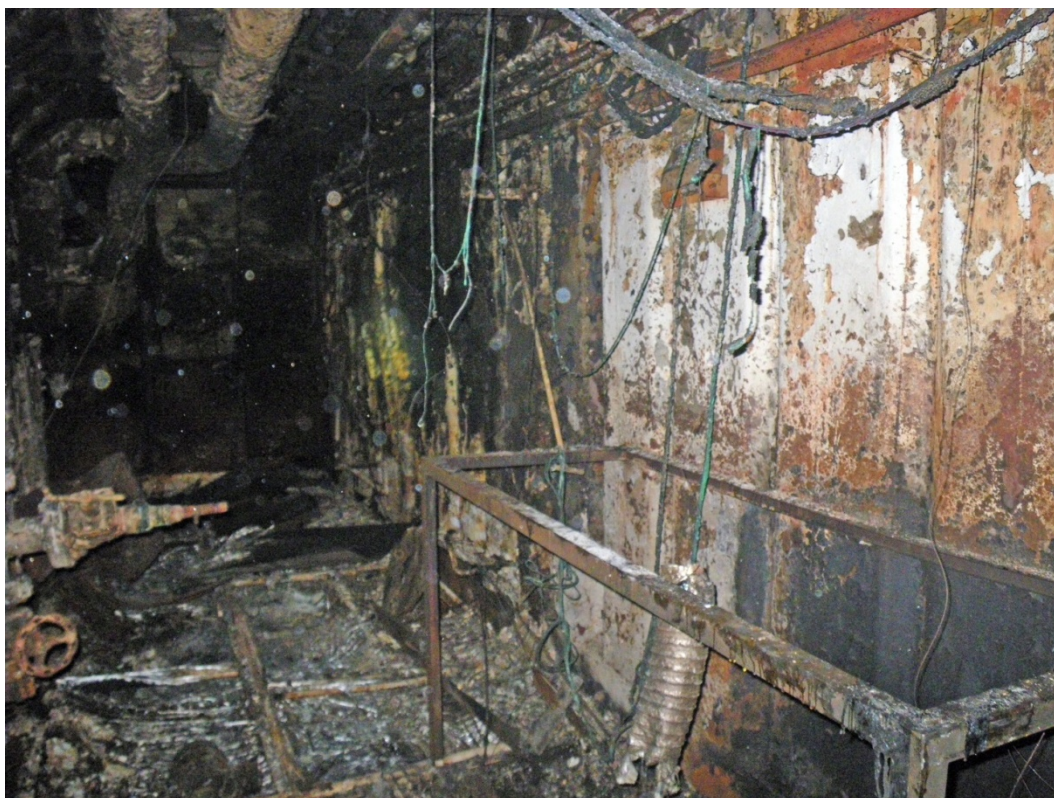
Figura 12. Mamparo exterior del cuarto de control de la factoría
