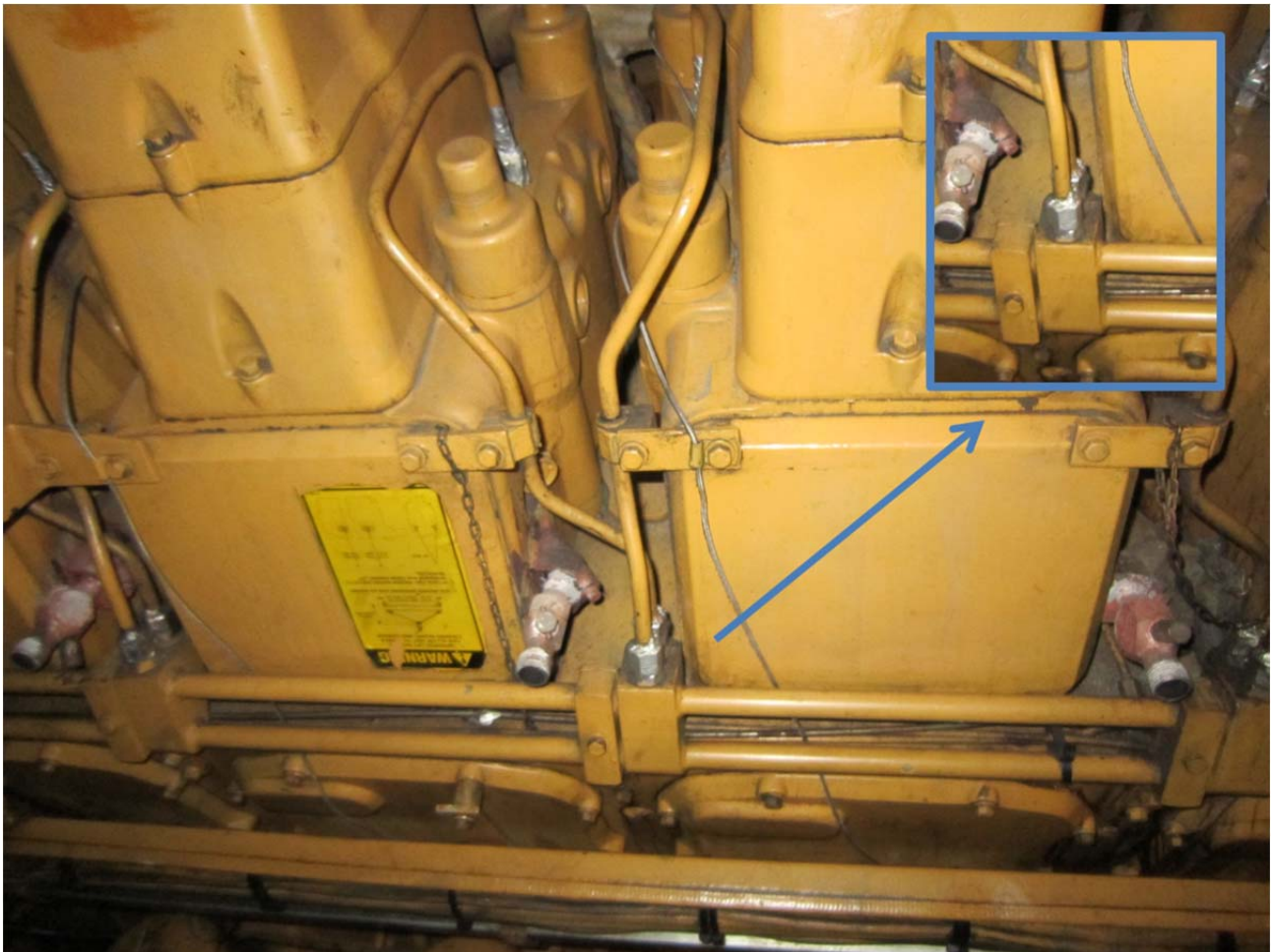
Figura 14. Cinta de aluminio sobre las juntas de los tubos de combustible.
