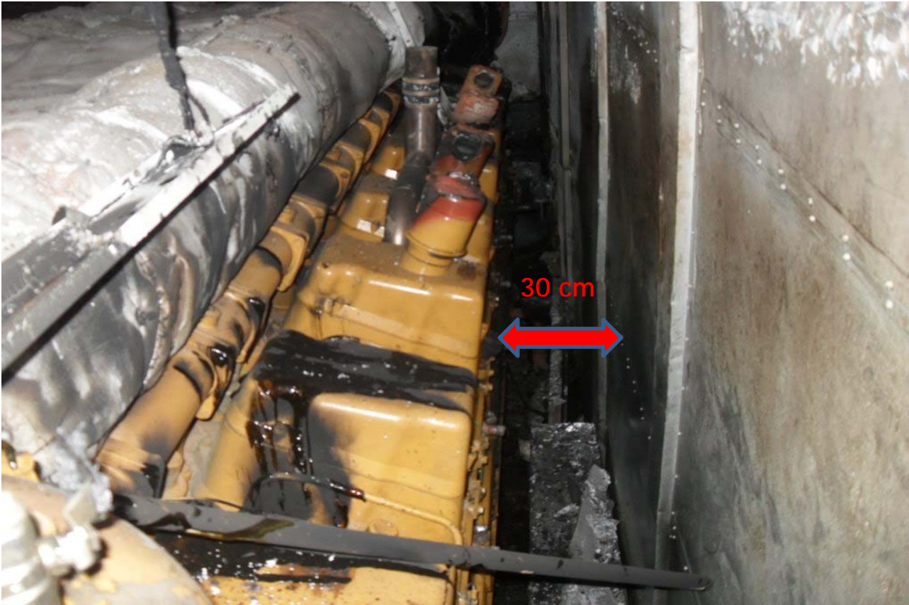
Figura 13. Vista del pasillo por el que la tripulación debería acceder para realizar una inspección visual efectiva.
