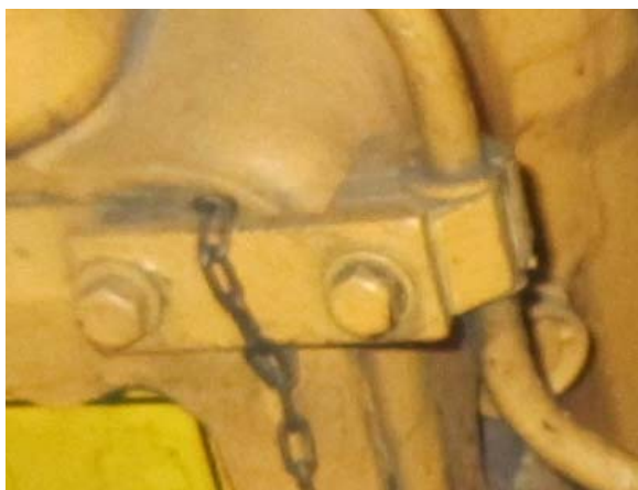
Figura 10. Detalle de una pieza de sujeción igual a la que faltaba en el tubo del cilindro nº16.
