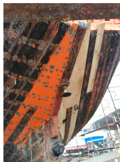
Figura 7. Reparaciones de la zona dañada
