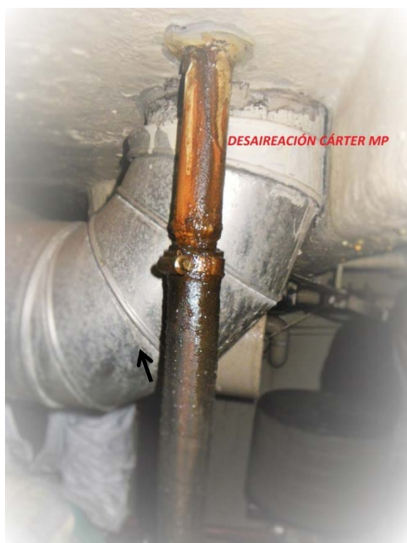
Figura 9. Tubería para desaireación del cárter
