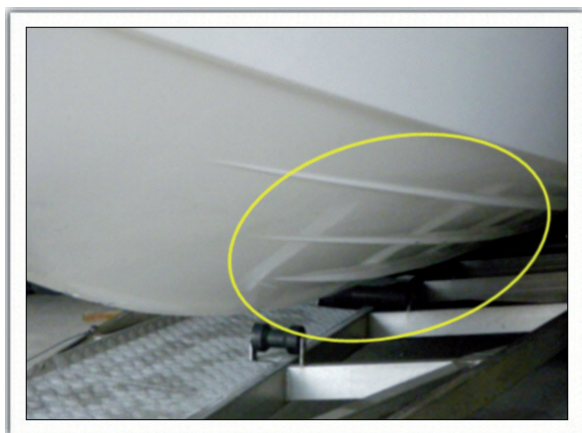
Figura 19. Daños en quilla de la embarcación MAR DE AGUIÑO
