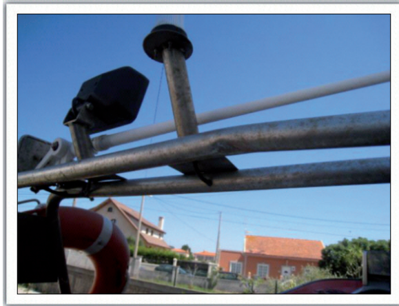
Figura 14. Daños en el pórtico de la embarcación VAI BEN
