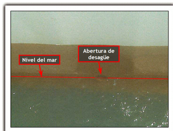
Figura 8. Abertura de desagüe de la cubierta principal en el costado de babor, en la zona del espacio vacío 03A1.
