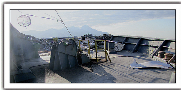
Figura 18. Daños en la proa del buque NEW GLORY
