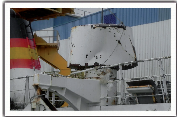
Figura 5. Toma de ventilación de la sala de máquinas, reparada de urgencia.
