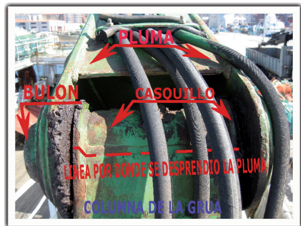
Figura 13. Grúa similar a la instalada a bordo del B/P MANUEL ÁNGEL NORES.
