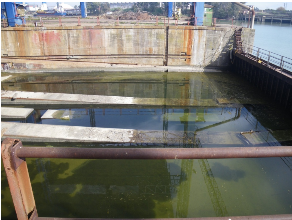
Figura 10. Detalle de la grada en el interior del Astillero
