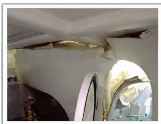
Figura 12. Consecuencias de la colisión en el techo del pañol de proa
