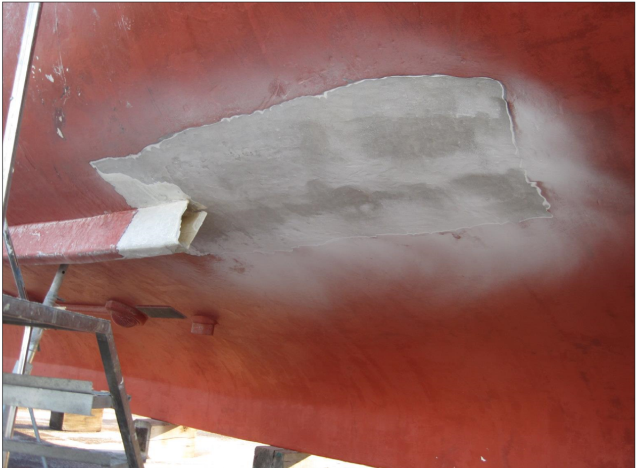
Figura 7. Reparación de la zona afectada junto a la quilla de balance
