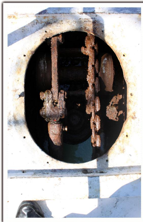
Figura 8. Escotilla para la revisión y mantenimiento de las pastecas
