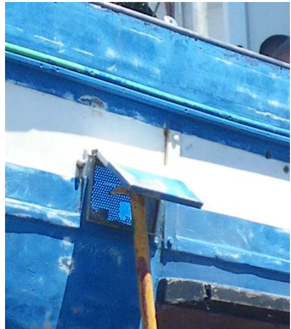
Figura 9. Detalle de la rejilla y tapa en una de las portas de desagüe.
