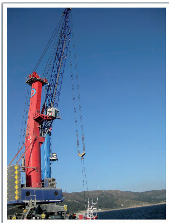
Figura 39. Grúas del Puerto Exterior de Ferrol
