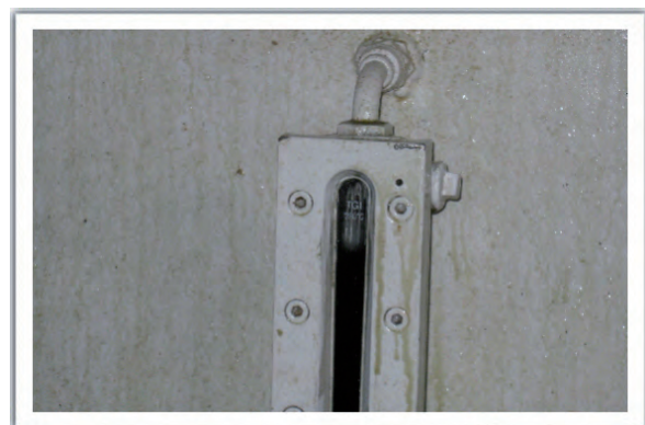
Figura 51. Nivel del tanque de estribor
