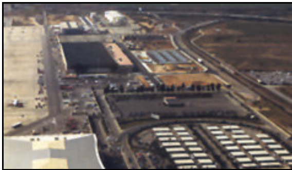
Centre de càrrega aèria de Barcelona
