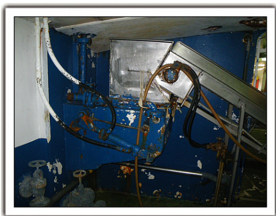
Figura 3. Tolva de desperdicios
