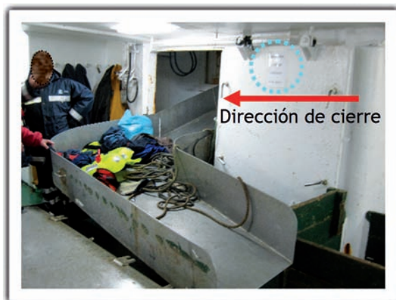
Figura 16. Canaleta obstruyendo el cierre de la puerta interior de la zona de salabardeo
